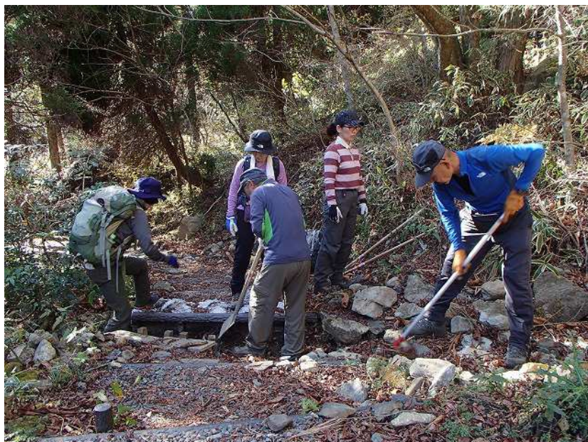
写真は登山道の溝構築作業の様子
